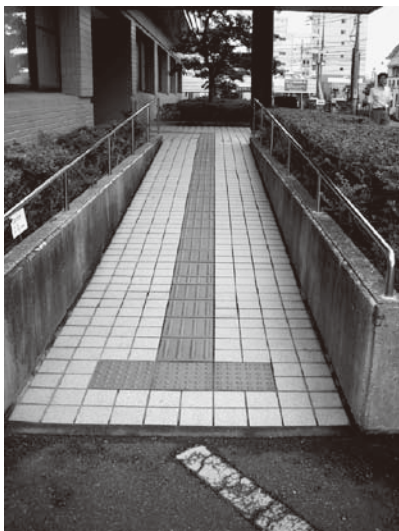
写真1 スロープ上に設置されている点字ブロック (宮崎市)
