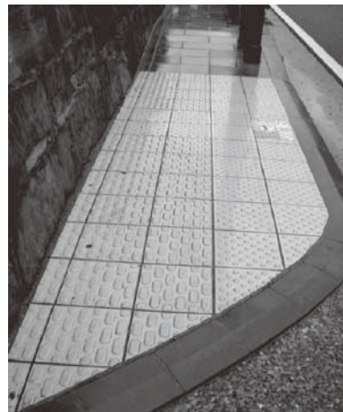
写真3 歩道の全面に設置されている点字ブロック（長崎県対馬市）
