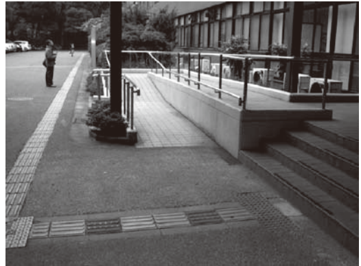
写真4 スロープではなく、階段に点字ブロックが設置されているケース（東京都文京区）
